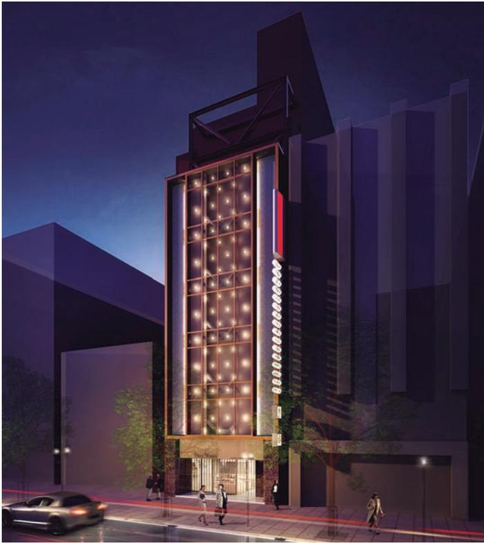
繁華街に位置するランドマークビルとして営業を続けながら、外部で耐震補強工事を行った事例。耐震補強を老朽化した建物における一つのステータスと捉え、補強部材の全てをあえて隠蔽せずに、外観デザインへ取り入れる計画を試みた。さらに道路からは見えない場所において、外観構成面の背後に空調換気設備のコアをマウントすることで、各階テナントの改装や入替時にオーナーが長年頭を悩ませてきた設備更新の問題を解決し、建物運営管理の節約化と健全化に成功
