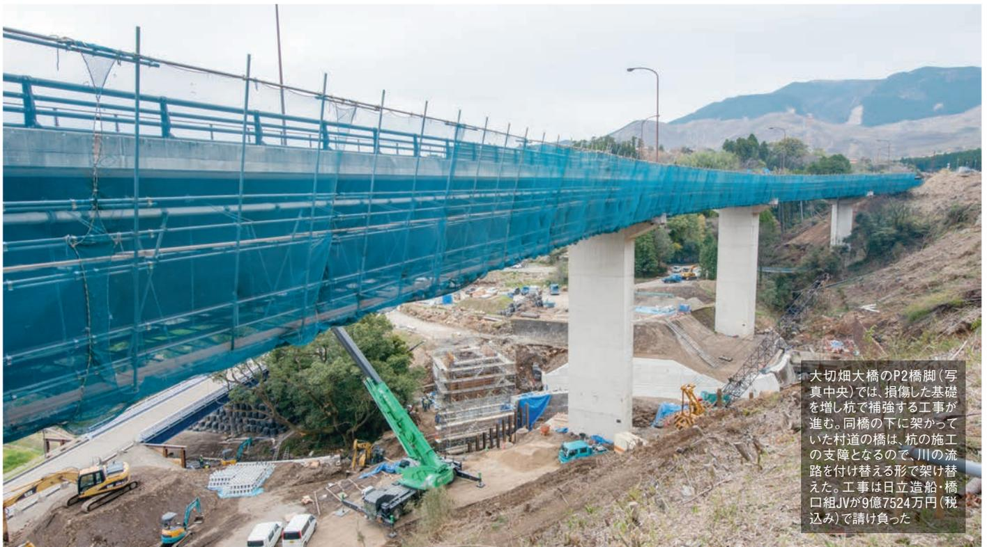
大切畑大橋のP2橋脚(写真中央)では、損傷した基礎を増し杭で補強する工事が進む。同橋の下に架かっていた村道の橋は、杭の施工の支障となるので、川の流路を付け替える形で架け替えた。工事は日立造船・橋口組JVが9億7524万円(税込み)で請け負った
