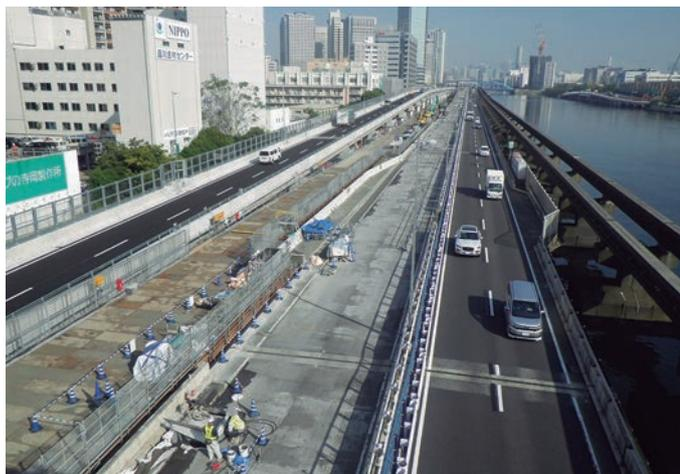
首都高速1号羽田線 東品川栈橋・鮫洲埋立部。通行を止めずに更新するため、上り車線の迂回路(左端)をまず造り、上り(中央工事中)を造り替え、完成後に下りとして暫定供用し、続いて現状の下り(右端)を造り替える。最終的に迂回路を撤去し、最初の上下線に戻して2026年度に工事は終了する
