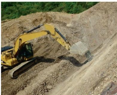
基礎岩盤面を清掃する「バックホーブラシ」。平鋼をほうきのように取り付けた
