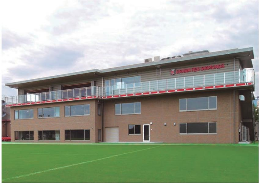
今秋完成した浦和レッズのクラブハウス増築棟。PC工法の強みを生かして柱のないトレーニングルームを実現した
