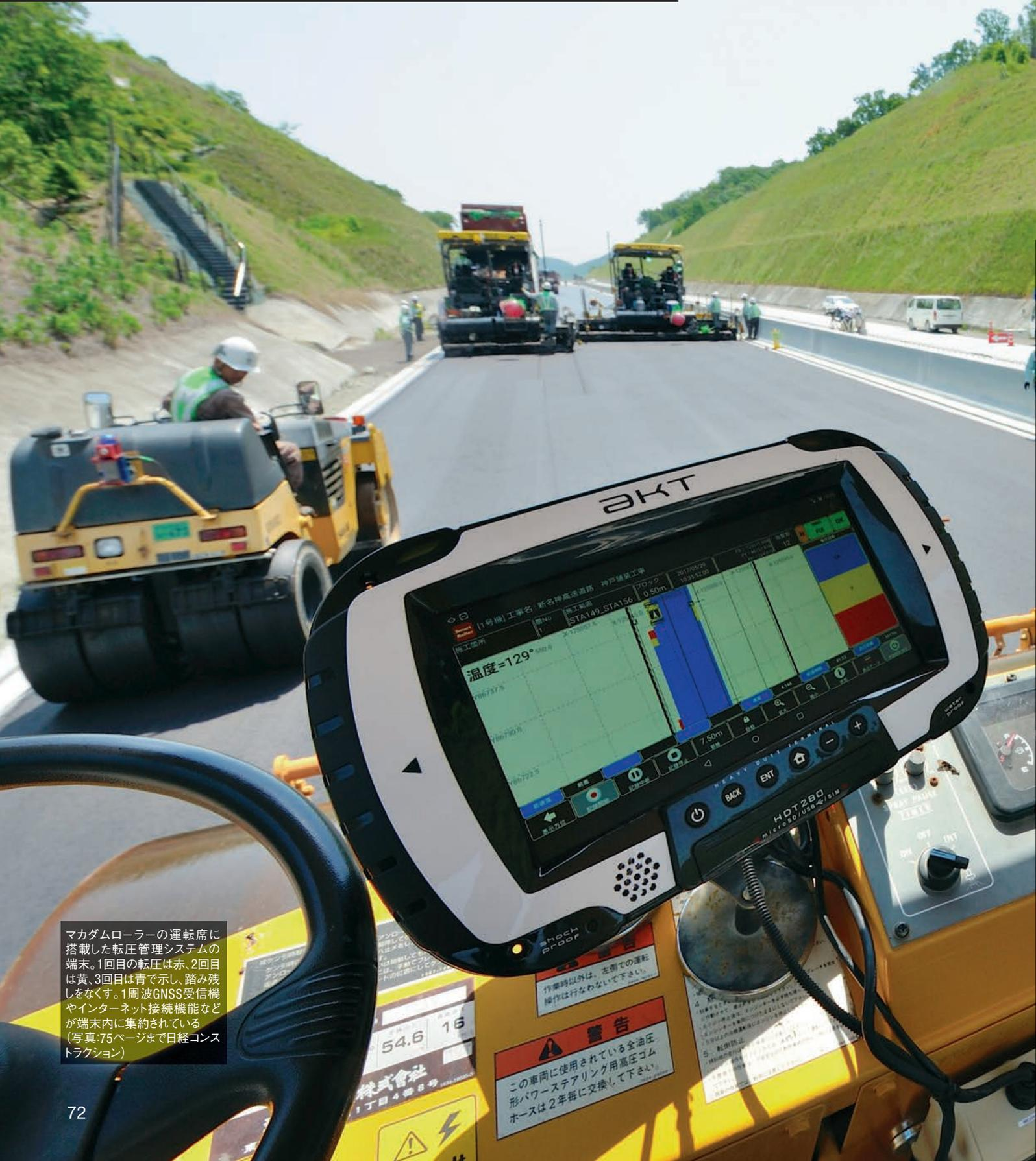
マカダムローラーの運転席に搭載した転圧管理システムの端末。1回目の転圧は赤、2回目は黄、3回目は青で示し、踏み残しをなくす。1周波GNSS受信機やインターネット接続機能などが端末内に集約されている(写真:75ページまで日経コンストラクション)
