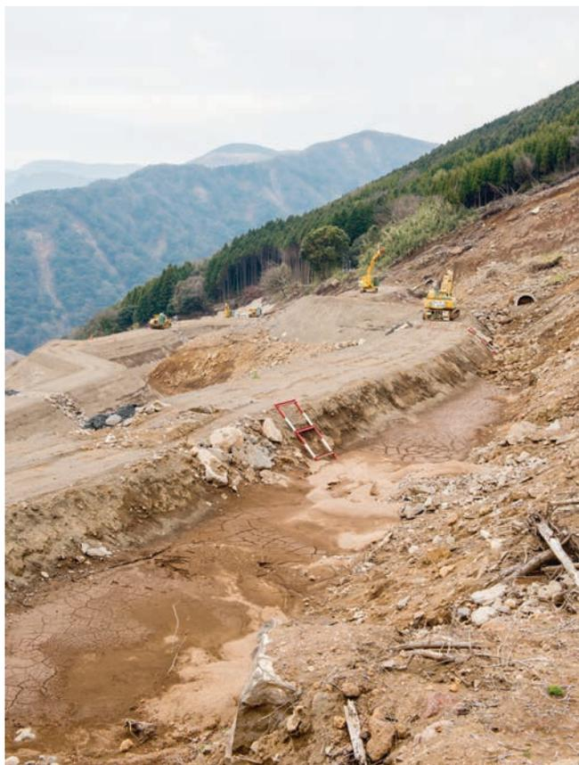
50万m<sup>3</sup>超の土砂が崩壊した阿蘇大橋地区に、無人化施工で築いた上下2段の土堤。現在は、下段の土堤に人が立ち入ることができる。上の写真は、阿蘇市側から土堤を見下ろした様子。上段の土堤のポケットには、雨などで流出した土砂がたまっている。右手奥に一部見えるトンネルは、水力発電用の導水路トンネルだ
