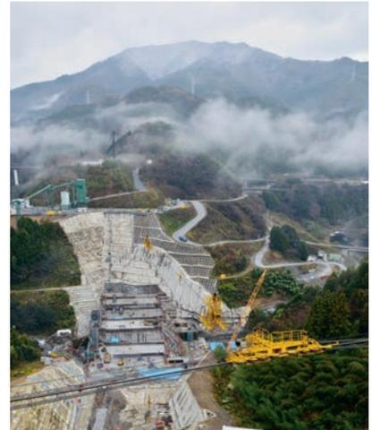
右岸側から見た軌索式ケーブルクレーン。手前の黄色い滑車が上下流方向に移動する
