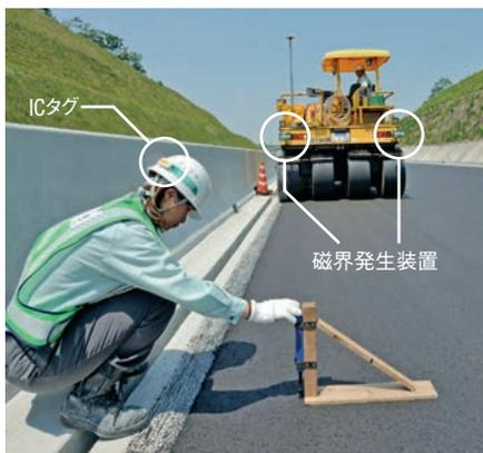
ヘルメットに取り付けたICタグでタイヤローラーを自動停止する。ICタグは施工者だけでなく、現場に入出入りする発注者などにも装着してもらっている
