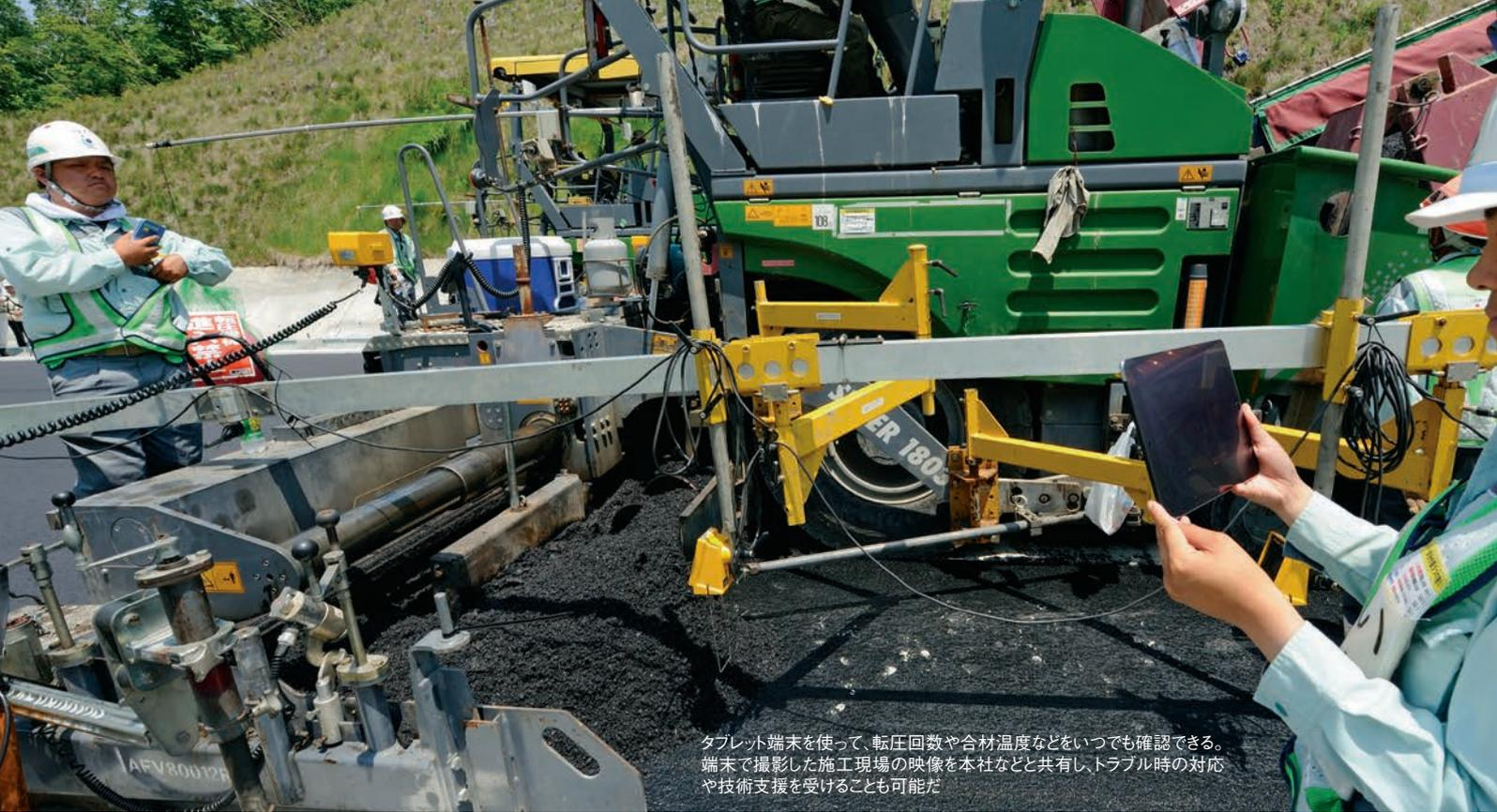
タブレット端末を使って、転圧回数や合材温度などをいつでも確認できる。端末で撮影した施工現場の映像を本社などと共有し、トラブル時の対応や技術支援を受けることも可能だ
