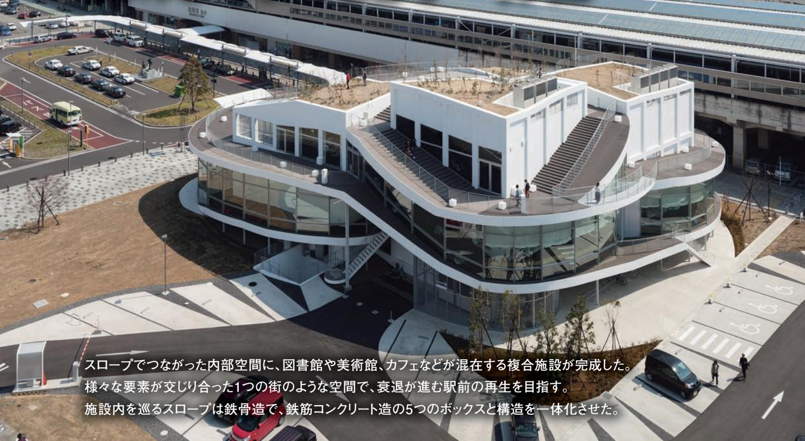
スロープでつながった内部空間に、図書館や美術館、カフェなどが混在する複合施設が完成した。様々な要素が交じり合った1つの街のような空間で、衰退が進む駅前の再生を目指す。施設内を巡るスロープは鉄骨造で、鉄筋コンクリート造の5つのボックスと構造を一体化させた。
