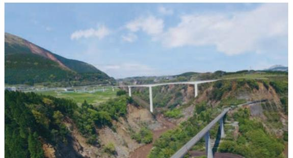
落橋した国道325号阿蘇大橋はPC3径間連続ラーメン箱桁橋に架け替える。上は完成予想図。手前は阿蘇長陽大橋(資料:国土交通省)
