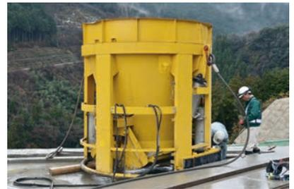
バケットを打設開始当初よりも1.25t軽くすることで、コンクリートの運搬容量を0.5m³増やした
