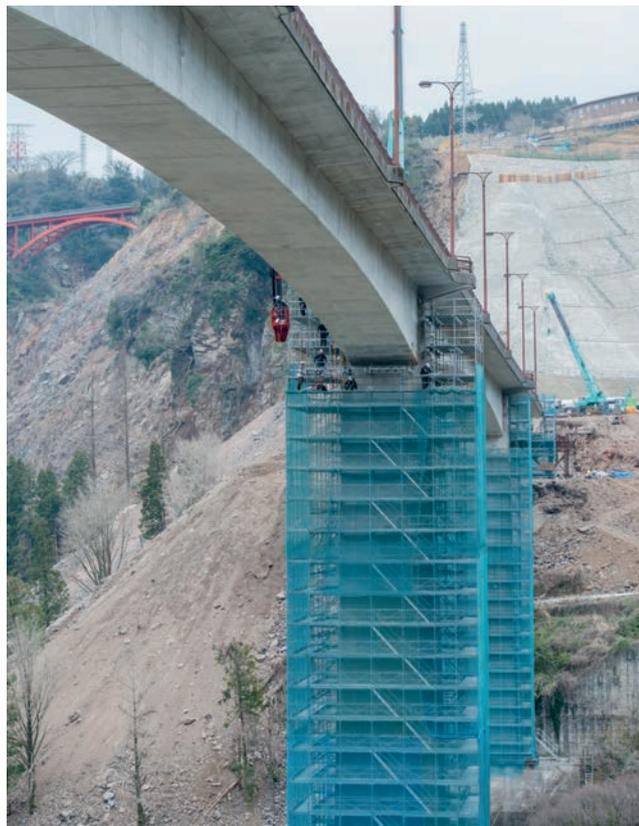
ひび割れが生じた阿蘇長陽大橋の橋脚を補修する様子。中空橋脚の内部にモルタルを充填し、鉄筋で一体化する
