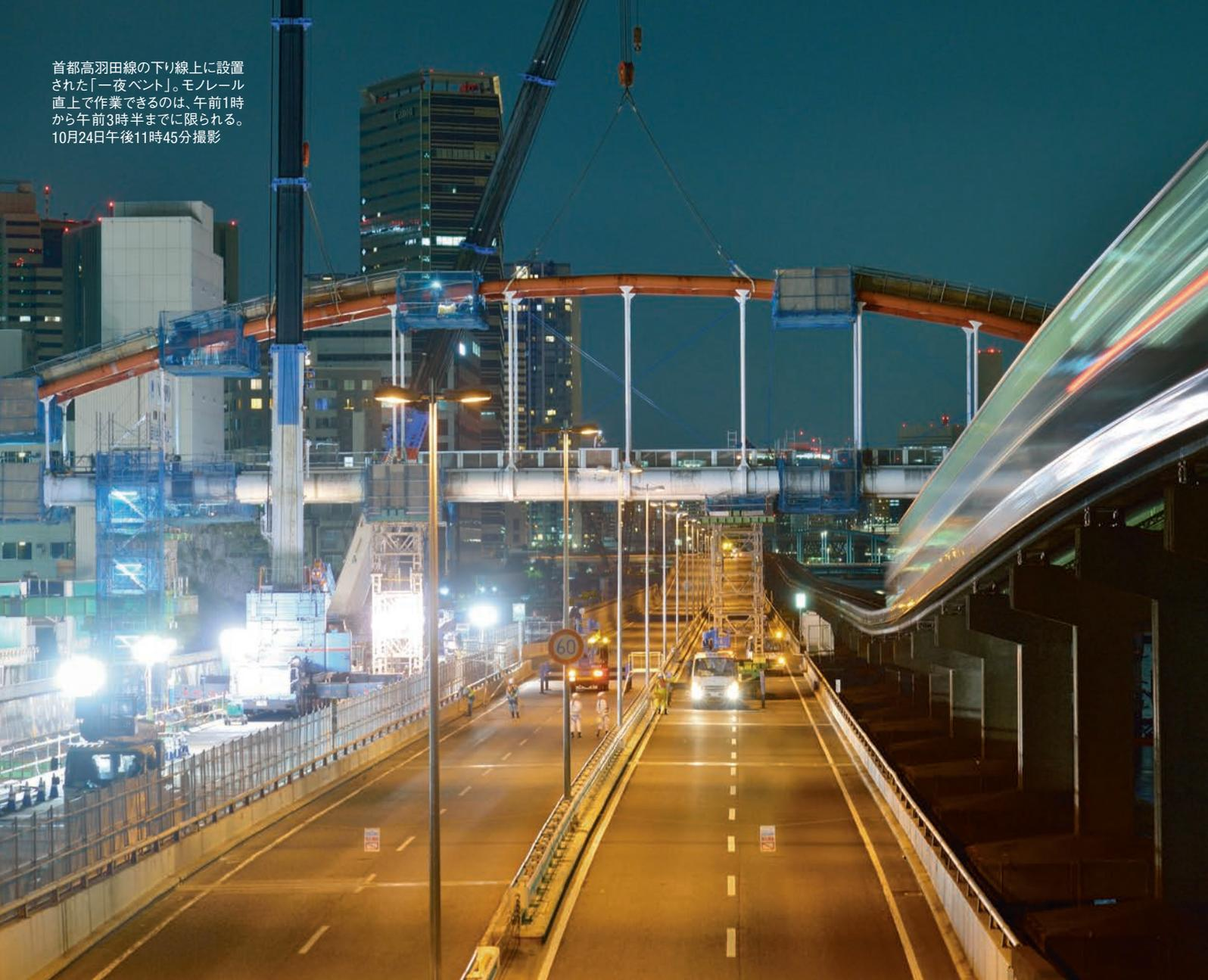
東京都品川区の臨海部を通る首都高羽田線の大規模更新工事に伴い、2016年9月から進められてきた大井水管橋の架け替えが17年1月に完了した。京浜運河を東西に横断する橋長165mの2径間ランガーアーチは、羽田線と交差する1径間がトラスへと姿を変えた。
