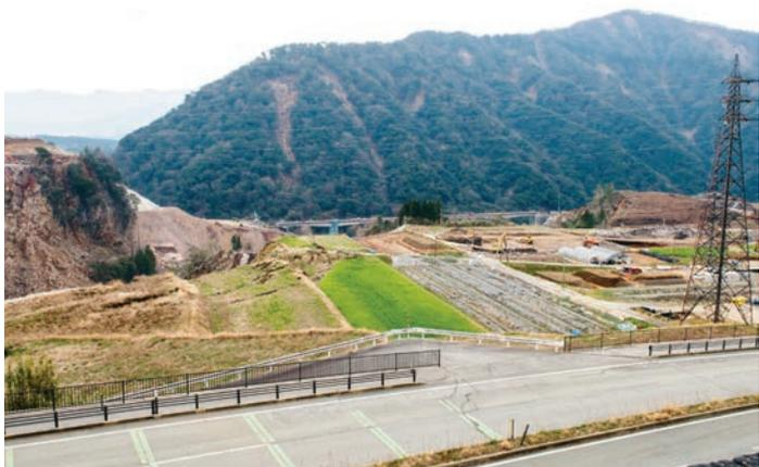
阿蘇大橋の架け替え予定地。写真左手奥の崖から、写真右の鉄塔付近までを結ぶ。延長は345mだ。橋梁形式は、PC径間連続ラーメン箱桁橋。大成建設・IHインフラ建設・八方建設地域維持型JVが約53億円(税抜き)で落札した。工期は2020年9月30日までだ
