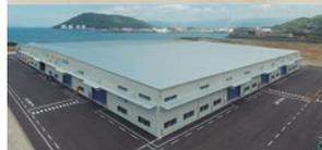
低層で大空間の建築で、システム建築は採用が拡大している(ポラテック西日本株式会社佐賀工場)
