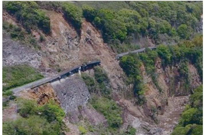
左は被災直後の阿蘇長陽大橋。橋台部が大きく沈下している。1993年に建設された橋長276mのプレストレスト・コンクリート(PC)ラーメン橋だ。右は斜面崩壊によって桁が一部落下した戸下大橋。95年に完成した橋長305m、17径間の橋だ(写真:国土交通省)
