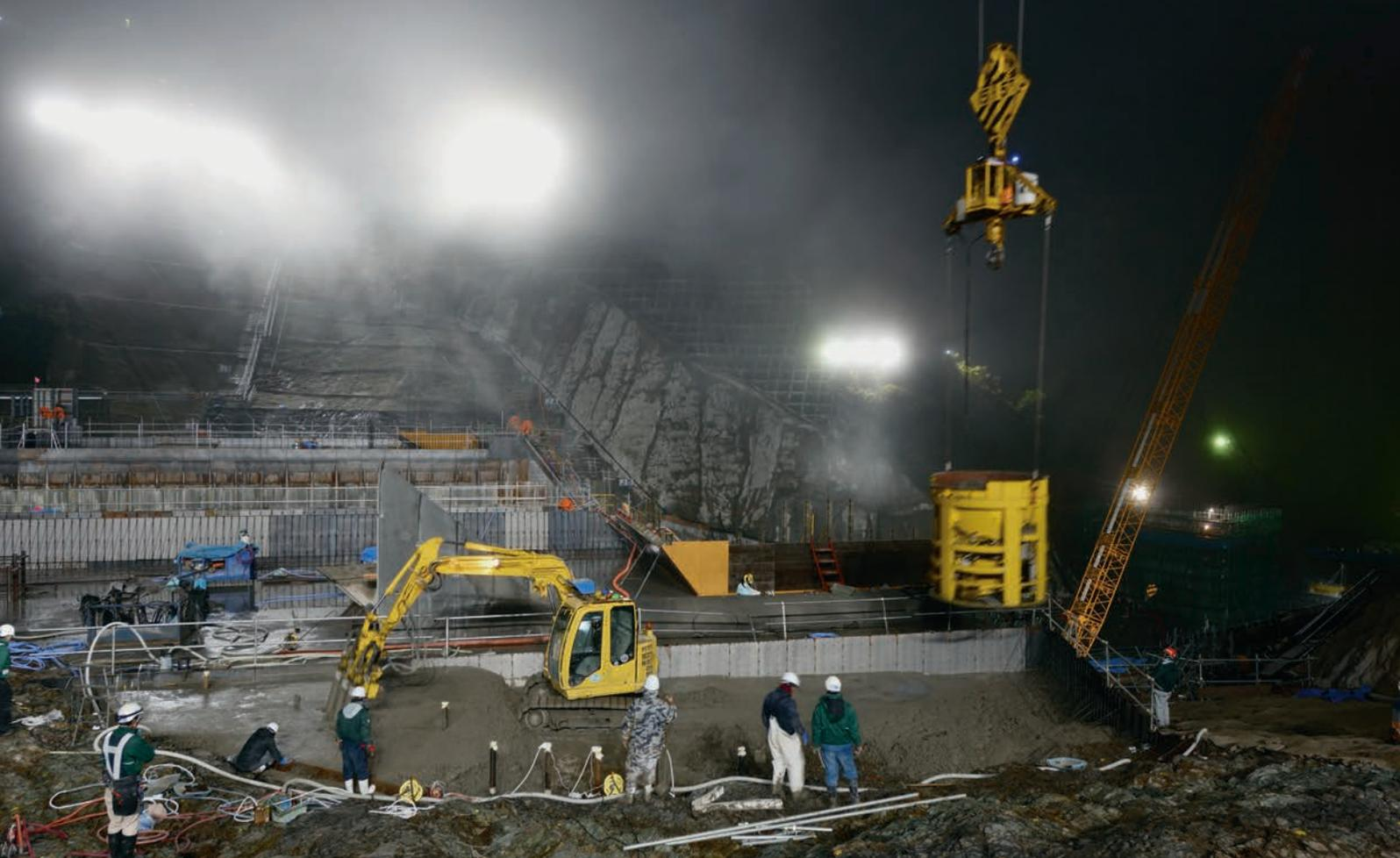
夜間の堤体打設。ケーブルクレーンで運搬したバケットからコンクリートを打設し、油圧ショベルに取り付けたバイプレーターで締め固める。ケーブルクレーンは1条しかなく、施工状況に応じて過ごとに打設の時間帯を決めている
