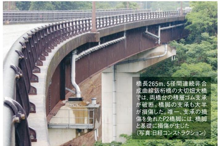
橋長265m、5径間連続非合成曲線鋼桁橋の大切畑大橋では、両橋台の積層ゴム支承が破断。橋脚の支承も大半が損傷した。唯一、支承の損傷を免れたP2橋脚には、橋脚と基礎に損傷が生じた(写真:日経コンストラクション)
