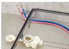
フレームに給水給湯配管・排水トラップを固定するので、フレームを設置した時点で、給水・排水の接続位置がわかります。
